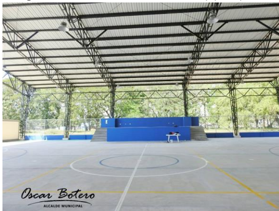
Imagen 11. Construcción canchas y parques urbanos
