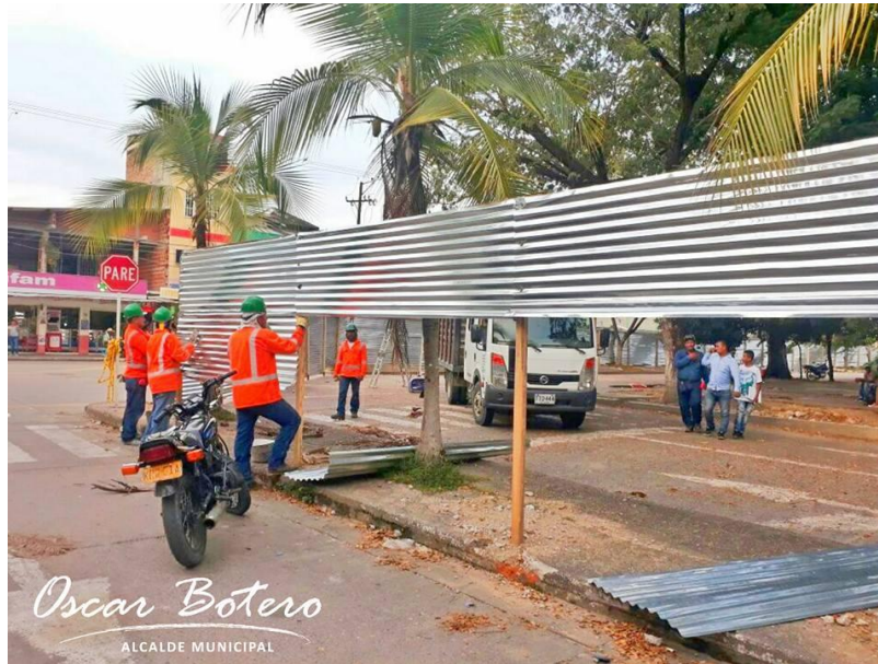
Imagen 10. Ejecución, remodelación parque Jorge Eliecer Gaitan
