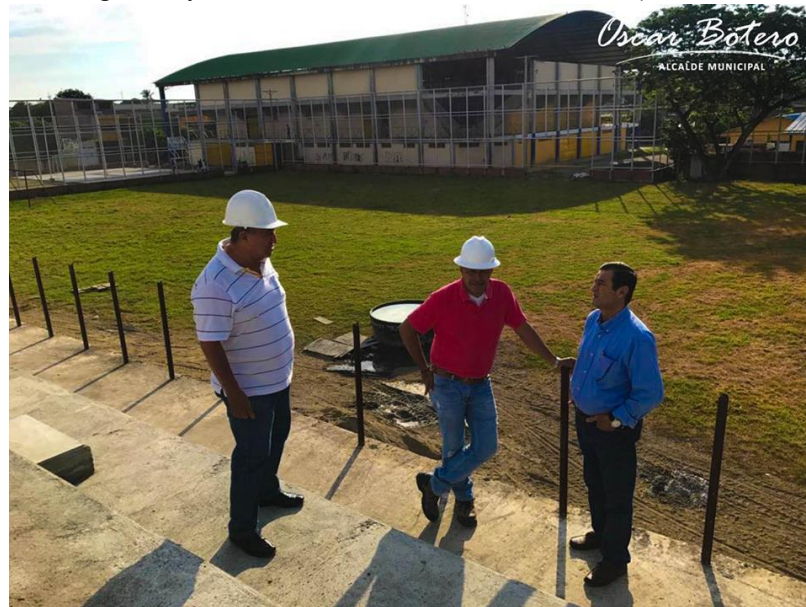
Imagen 9. Ejecución de obras en el Coliseo Municipal
